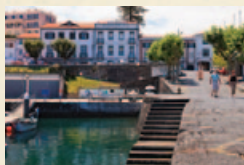
17 Edifícios dos escritórios da Casa Bensaúde e da Sociedade de Carvão e Fornecimentos de Fayal (séc. XIX).
